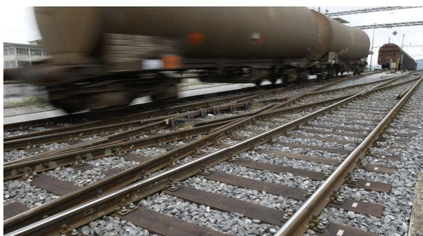
Bei Entgleisungen brechen die Holzbahnschwellen trotz Aufschlag der Metallräder nicht. Kommt es zu einer Entgleisung bleibt die Spurweite bestehen und somit die Gleisanlage befahrbar. Dies ist nicht der Fall bei Entgleisungen auf Beton- und Stahlschwellen. Betonschwellen Brechen und Stahlschwellen verbiegen sich.
